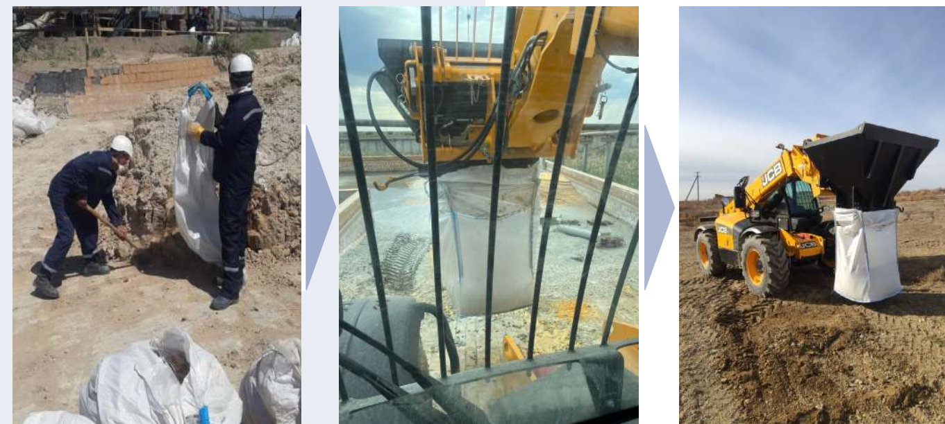
Рис.№3 Сравнение процесса затаривания ТРО до и после внедрения установки / Fig.№3 Comparison of the process of packing SRW before and after the installation
